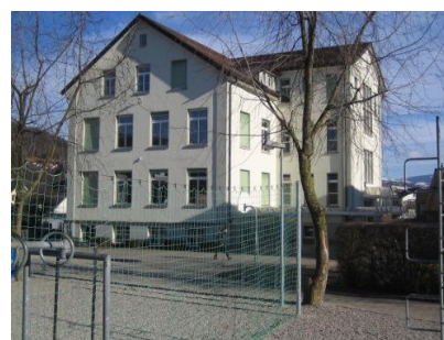
Schulhaus Dorf, Eschenbach
